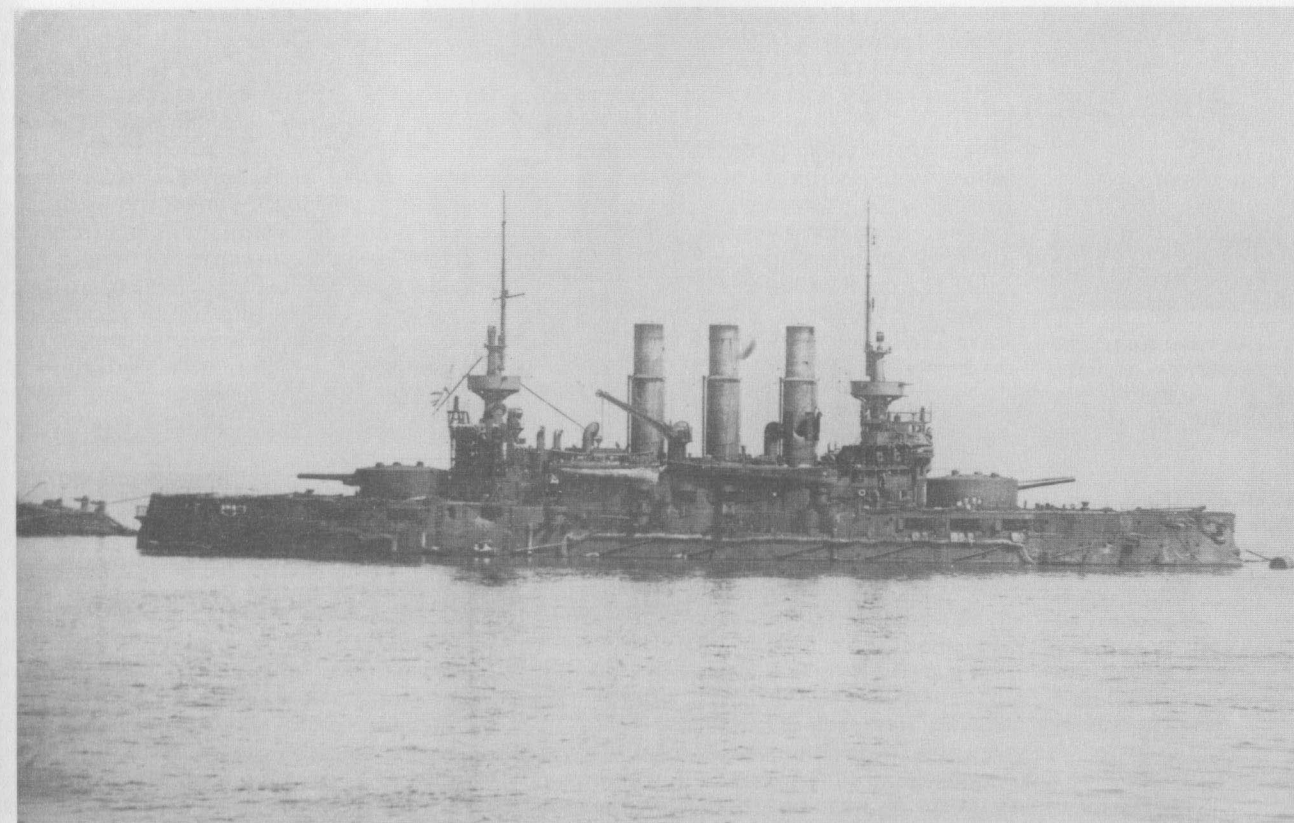
«Ретвизан» после боя 28 июля — вид повреждений правого борта. Бросаются в глаза две огромные пробоины в районе каюты командира и развороченный взрывом кожух первой дымовой трубы.
